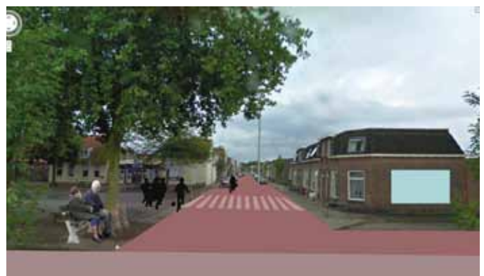
fig. 43b Enkstraat na ingreep. De straat loopt volledig door tot aan de Boxbergerweg en getracht is dichte plinten te openen door ramen te plaatsen
