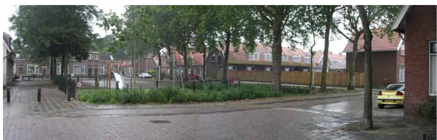
fig. 49 Situatie waarin het transformatorhuisje is verwijderd. Zicht vanuit de woningen die hierachter stonden is nu weer gericht op het plein.
