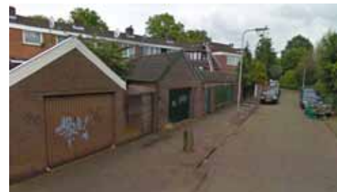
fig. 27 Blinde plinten langs de spoorzone
