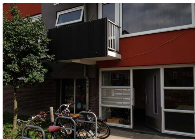
fig. Huidige situatie - Onveilige situatie - Balkons makkelijk in te klimmen door plaatsing van fietsenrekken
